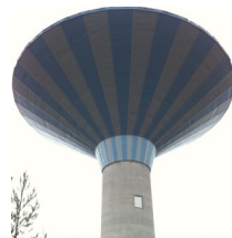
ALARM i vanntårn, Finland
