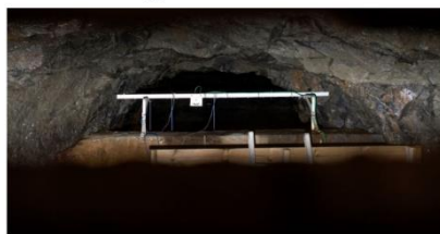
Det har vært flere tilfeller der forurensning har kommet inn i drikkevannsanlegg gjennom sprekker i fjell. Denne typen fjellbasseng er en risiko, mener Folkehelseinstituttet.
